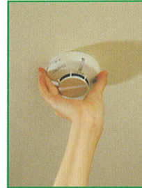
天井への設置
